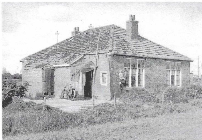
De "Mallemlen" te Harkema, hierin woonden vier gezinnen. Destijds afgebrand. Op de foto Tije Vaatstra met dochter Geeske op de arm. (uit: "25 jaar Doarpsbléd Harkema")
